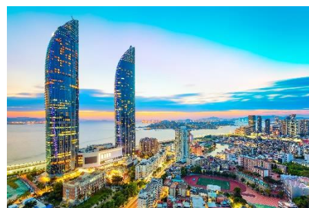
外觀廈門標誌性建築【雙子星塔】
